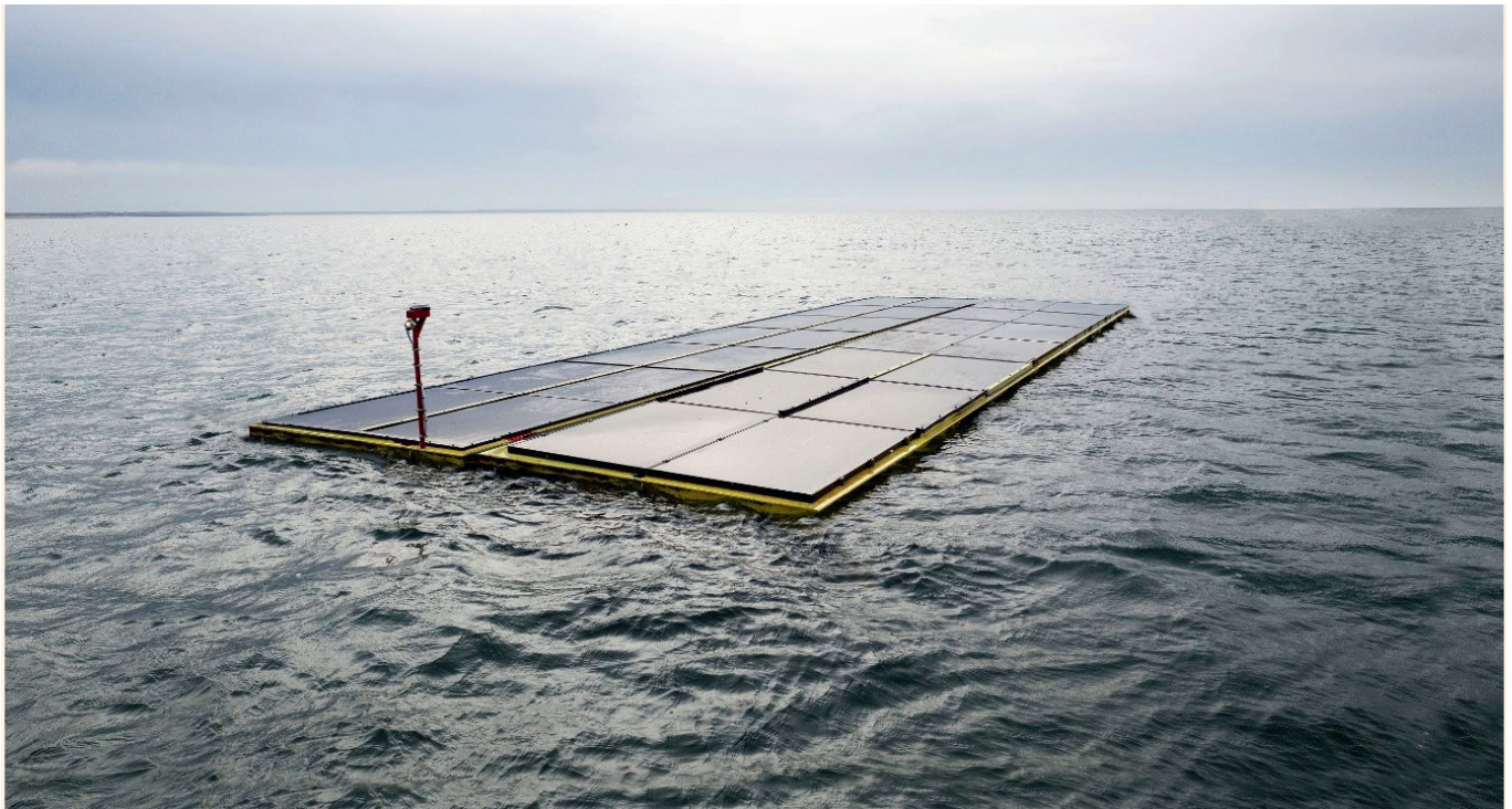
La plateforme de test Blue Accelerator s'apprête à être reliée à des panneaux solaires flottants. © OCEANS OF ENERGY
